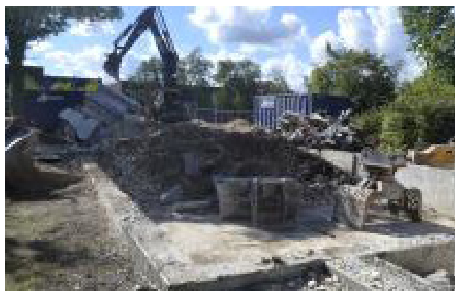
Byggeriet er så småt gået igang. Det tidligere sproghus er revet ned
