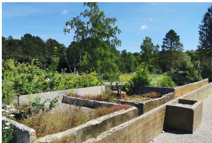
Rå beton med vegetation på vej
