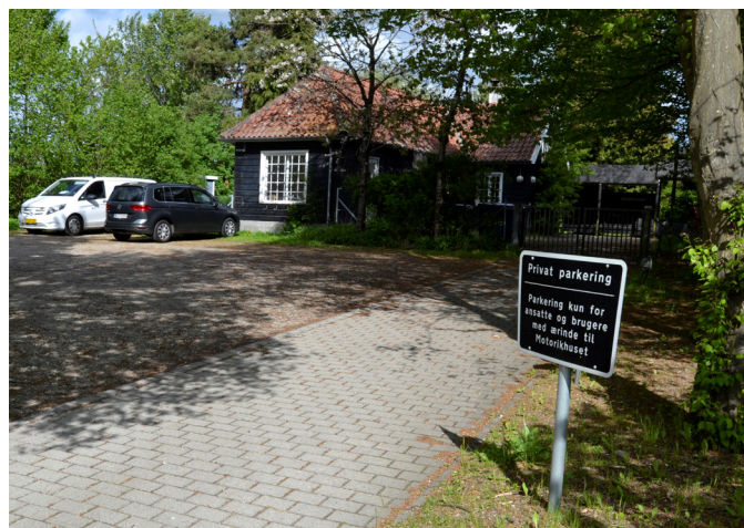
Parcelvej 151 samt nabohuset er ejet af Lyngby Taarbæk Kommune
