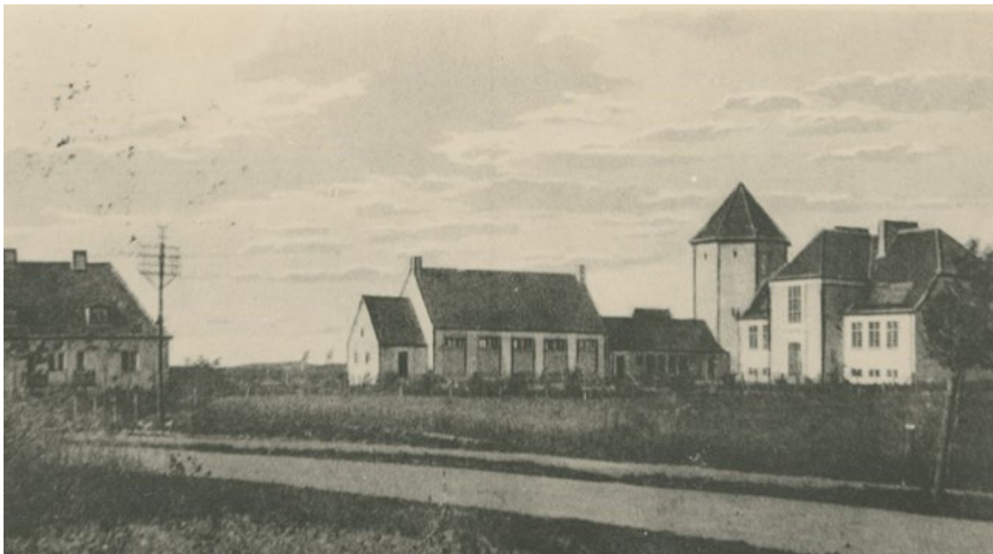
Den nybyggede Virum skole, med vandtårn og inspektørbolig fra 1920, på Parcelvej 165. Ukendt fotograf. 1920.
