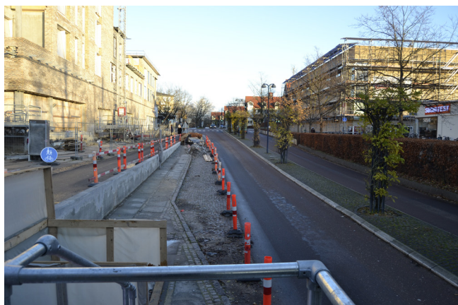
Overgang på Frederiksdalsvej - en central del af det nye projekt
