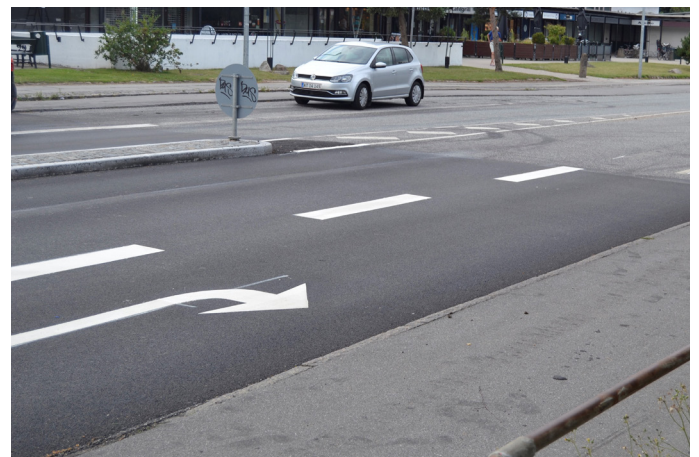
Ny asfalt og ny afstrikning, men ikke ved Sorgenfri Torv.
