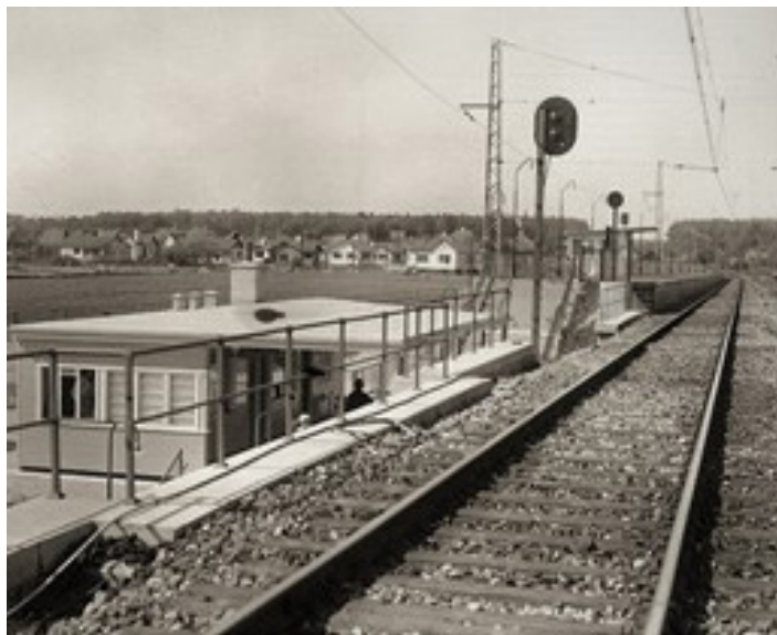
Virum station set fra perronen mod København, rækværk og ledeværker, tv. viadukt for Frederiksdalsvej og mellembloksignal, th. cykelparkering. Fra Jernbanemuseets billedsamling Lb.nr.: 0249-023 Ukendt fotograf. 1937.
