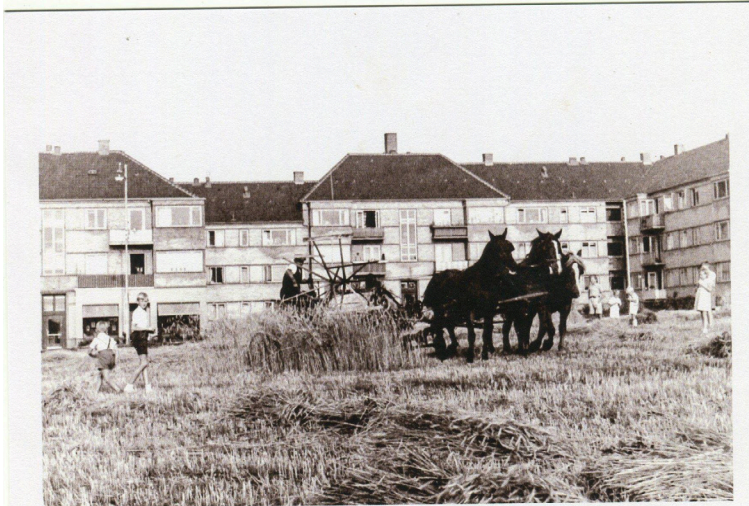
Landbrugsmaskiner udfør Helleholm på Grønnevej.
