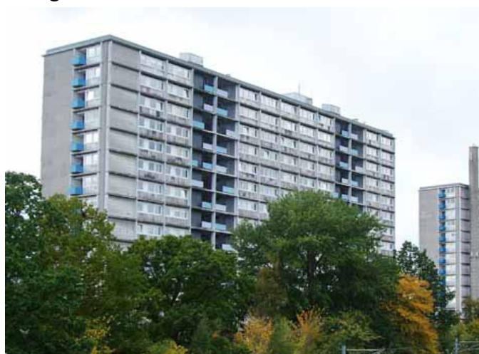
Højhusene som de så ud før renovering.
