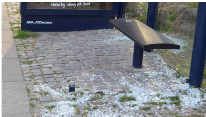
Vandalisme i et buskur.
