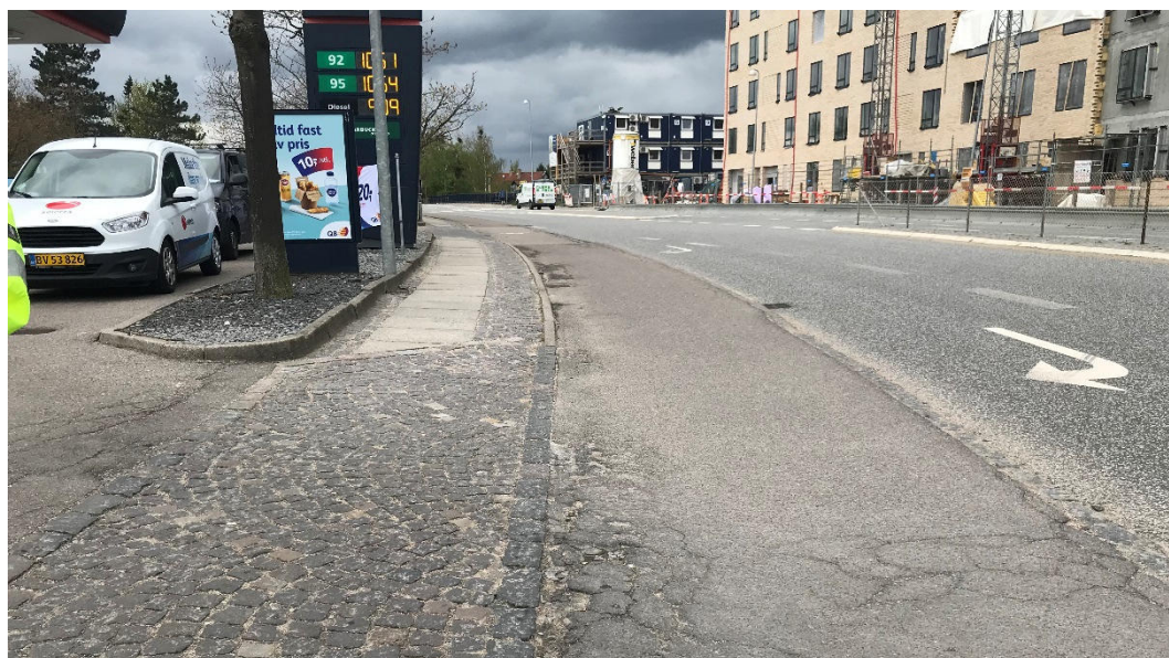
Foto 5: Nedslidt belægning på sydlig fortov og cykelsti
