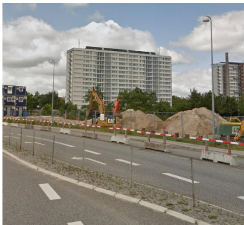
Foto 7: Eksisterende belysning med Københavner Armatur, Philips. Kilde: Google Streetview
