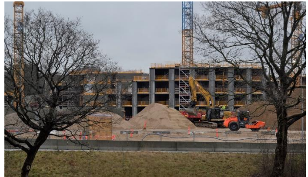
Byggeriet på plantedirektoratets grund er nu oppe i 4 etager
