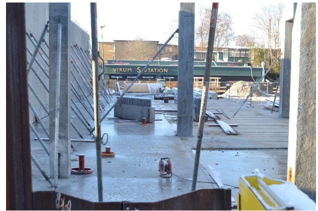
Byggeriet på posthusgrunden er kommet over jorden.
